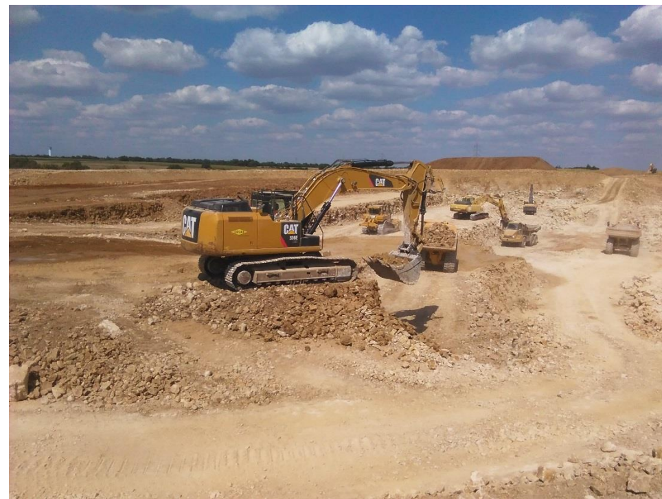
Figure 15 : construction de la réserve de substitution de Saint Benoist sur Mer, Terrassement été 2016
