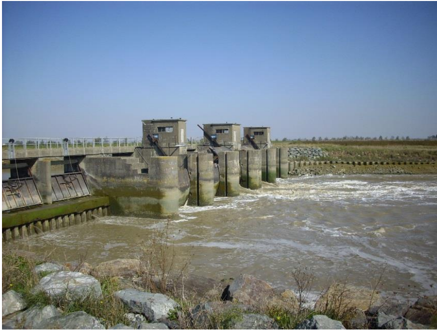
Figure 30 : barrage du BRAUD dans l'estuaire du LAY
