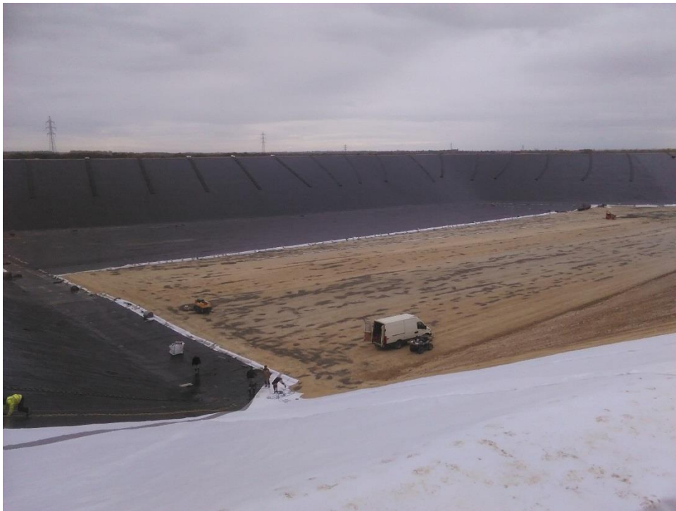
Figure 27 : pose de la géomembrane EPDM - réserve de Saint Benoist sur Mer (novembre 2016)
