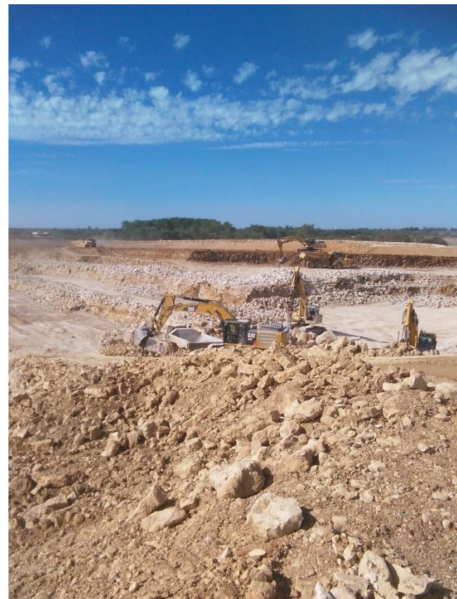
Figure 26 : phase de gros terrassement de la réserve de Saint Benoist sur Mer (été 2016)
