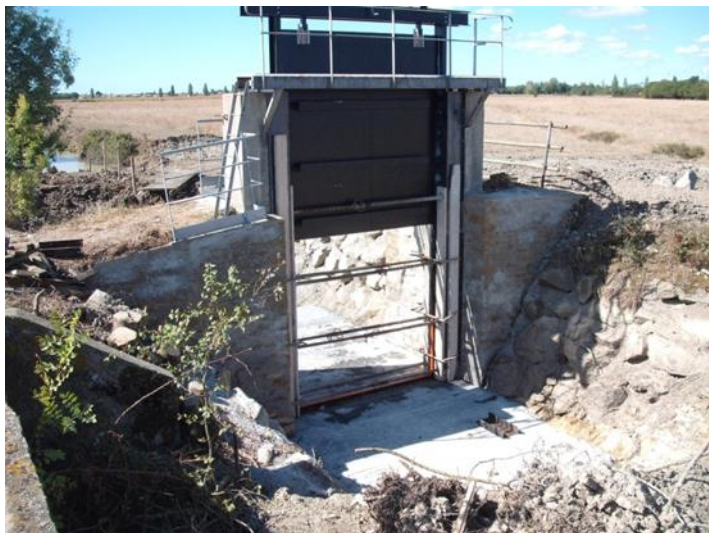
Figure 34 : restauration de la porte de la Cale
